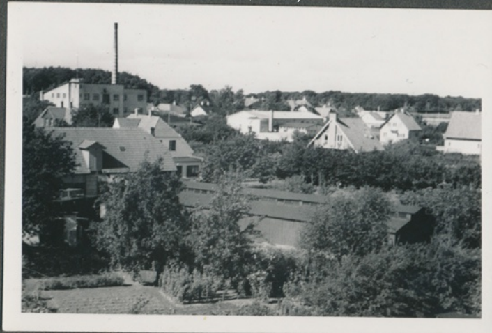
Stationsvej 12 i Hjallesø, fabrikkens bagside, man kan se lidt af huset og verandaen (negativfilm 5, nr. 15)
